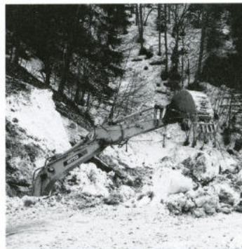
Bild links: Strasse hinter der „Eisernen Brücke“ im März 1999.
